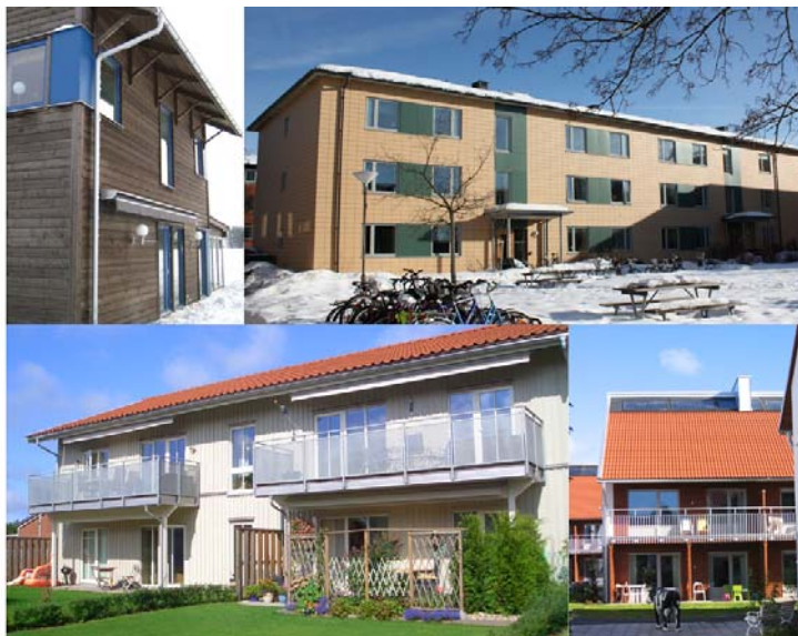
Figur 14 Passivhus i Lidköping, renoverade passivhuslägenheter i Alingsås nya passivhuslägenheter i Frillesås och i Värnamo (bilder: Ulla Janson).
